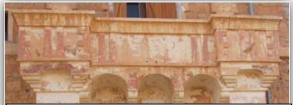
Figure n° 10: Vue sur la corniche
