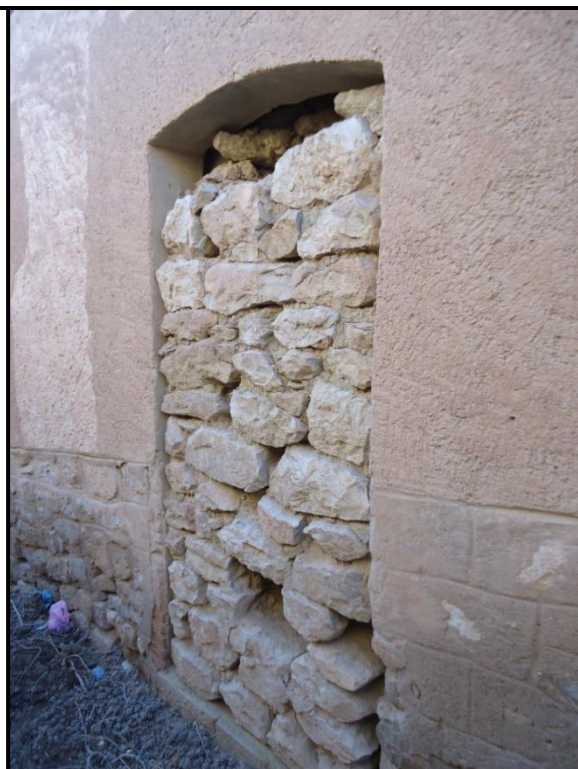
Figure n°27: accès au fort par cette porte
