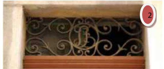
Les garde-corps de fenêtres sont très exposés aux intempéries. Plus le décor est riche plus il est fin et fragile. Quant il participe à la structure, sa détérioration peut entraîner la ruine de
