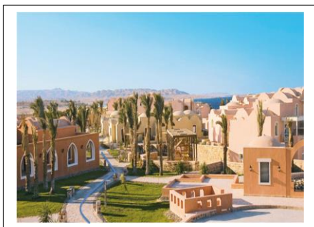
Fig.04 : voies piétonnes Source : Web
