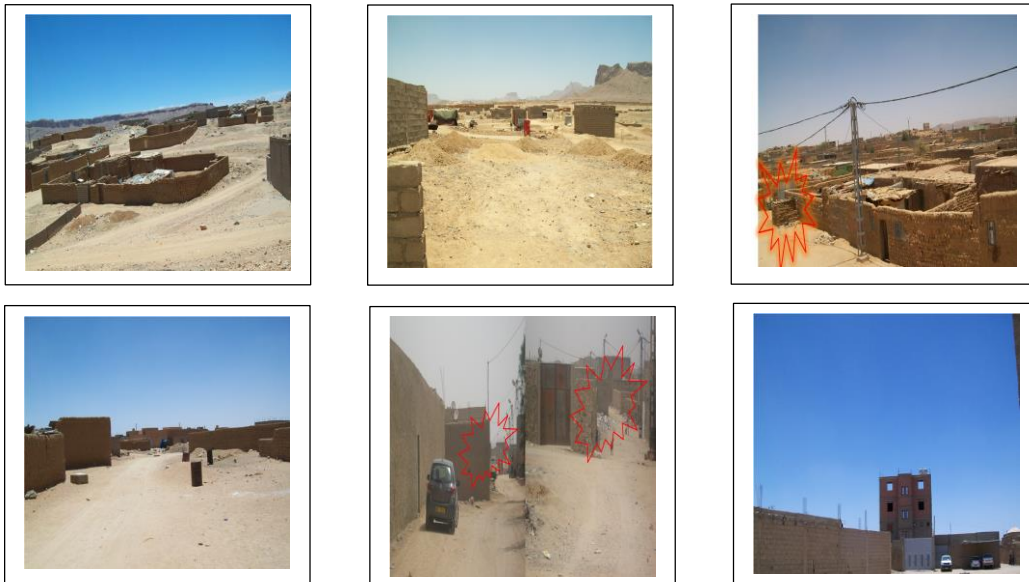
Fig.76 : Habitats dégradés dans l'extension à l'ouest Source : URBAB
