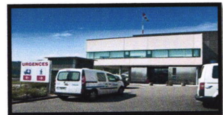
Figure 18 : Le service d'urgence est accessible en plein pied.
