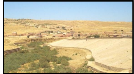
Fig.35. vue sur oued Chélif. Source : photos prise par l'auteur.
