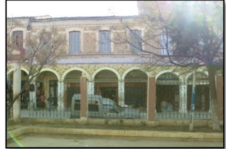
Fig.34. vue sur les arcades. Source : photos prise par l'auteur.
