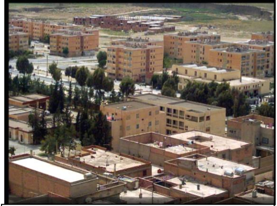
Figure.3.32. : Photo sur la nouvelle extension Sud. Source : photo prise par l'auteur.
