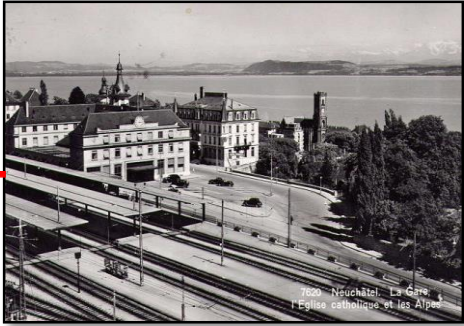
Fig.10 : l'ancienne gare/ source : google.com
