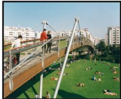
Vue de la passerelle BZ/12 surplombant le jardin de Reuilly .
