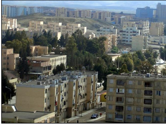
Figure.3.31 : Photo sur la nouvelle extension Sud. Source : photo prise par l'auteur.
