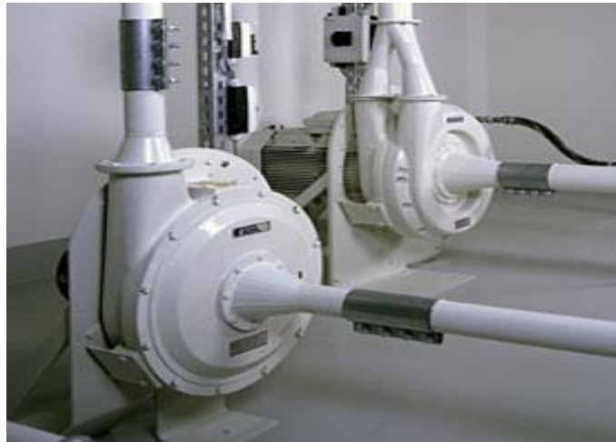
Figure 1.8. Compresseur de l'air.
