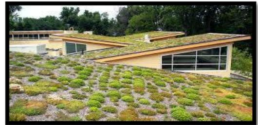
Figure III.30 La récupération des eaux pluviales à travers les terrasses végétalisées source : www.ecohabitation.com
