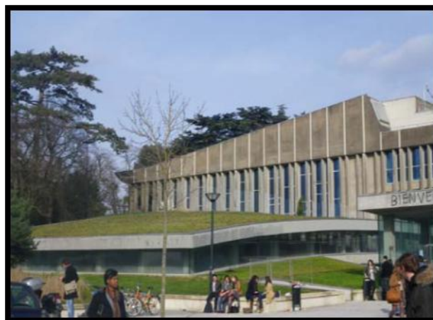
Figure II.73 : Toiture végétale de l'université de Nantes Source : Guillaume Pommier, Damien Provendier, Caroline Gutleben, Marjorie Musy : IMPACTS DU VÉGÉTAL EN VILLE, 2014.pdf
