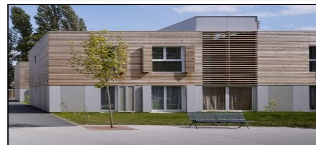
Figure II.62, 63 : En haut Façade Est, En bas Façade Ouest Source : http://www.actuarchi.com/2011/03/26-logements-bbc-tourcoing-atelier-981/#prettyPhoto[gal_2]/0/
