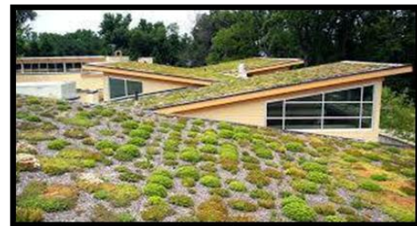
Figure III.27 : La récupération des eaux pluviales à travers les terrasses végétalisées. Source : http://www.ecohabitation.com/guide/toits-vegetaux-etape-etape-avantages-inconvenients
