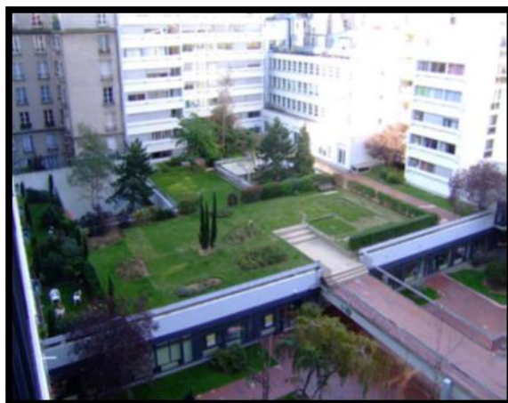
Figure II.72 : Toiture végétale Paris France Source : Guillaume Pommier, Damien Provendier, Caroline Gutleben, Marjorie Musy : IMPACTS DU VÉGÉTAL EN VILLE, 2014.pdf
