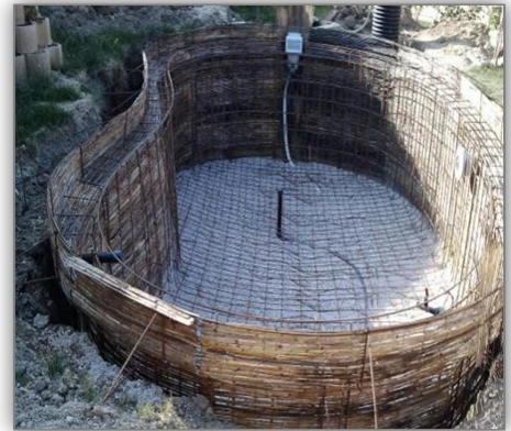
Fig. 10: piscine au cour de construction
