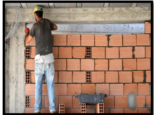
Fig. 05:mur en maçonnerie(la brique).
