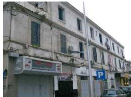
Figure 3.35 : Vue de l'extérieur de la maison
