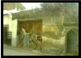
Figure.3.38 : une maison précaire. ; Sr:
