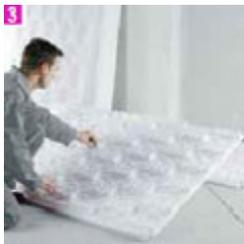
3- Posez les plaques en vérifiant le bon emboîtement et l'alignement correct des plots. Posez soigneusement l'ensemble des plaques sur tout le niveau à chauffer. Vérifiez que les plaques sont bien en contact avec le relevé de plinthe, afin d'éviter d'éventuelles infiltrations de béton.
