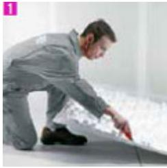
1 - Coupez les mortaises placées contre les cloisons. La découpe des dalles est effectuée avec un cutter, une scie égoïne à denture fine ou le coupe-plaque fabricant.
