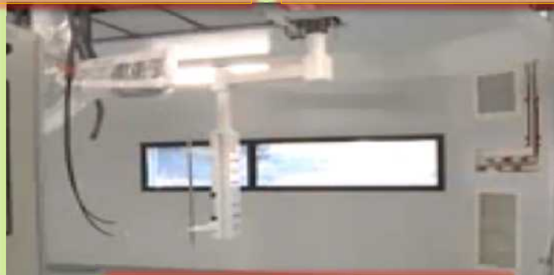
Fenêtre salle d'opération
