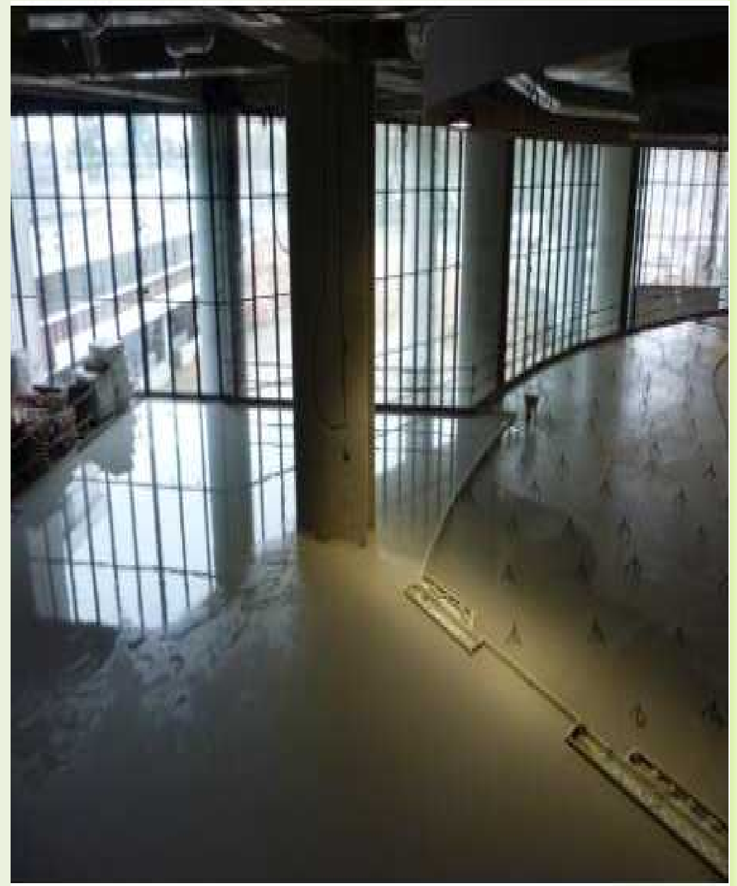
Coulage de la chape du hall avant pose du carrelage.
