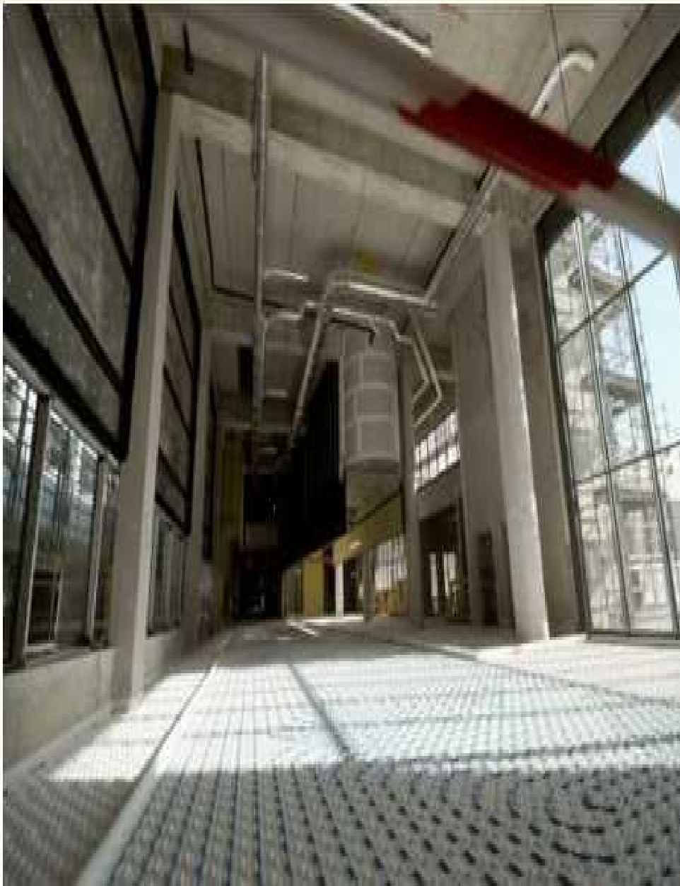
Pose du plancher chauffant (serpentins sur polystyrène).
