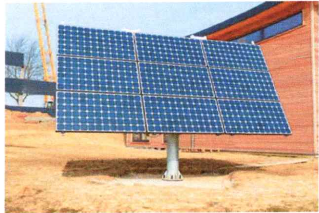
Figure 64 : Un suiveur solaire peut avoir deux degrés de liberté de rotation : horizontal pour régler l'azimut et vertical pour l'inclinaison.
