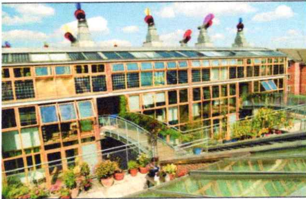
Figure 26 : image du quartier BedZED
