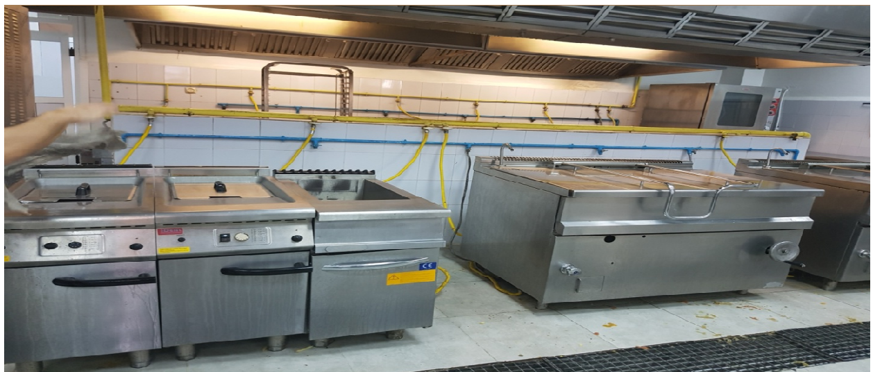
Figure 6 : La cuisine en cours de nettoyage
