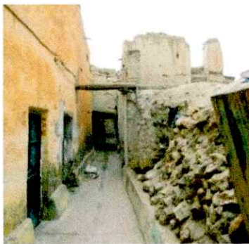
Fig.53 : S'quifa à démolir Source : auteur.
