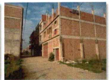
Figure 3.55 habitation de R+3 sur les lieux
