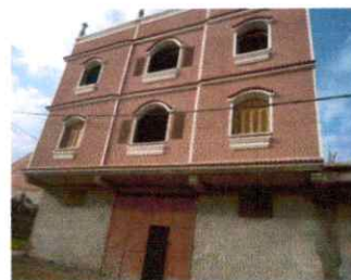
Figure 3.54 habitation de R+2 sur les lieux
