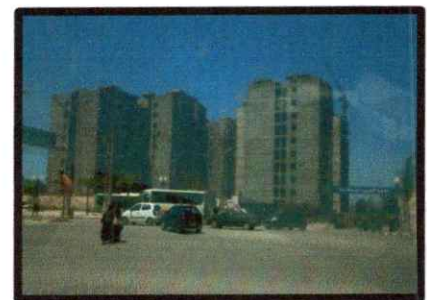
Figure 3.62 Habitat collectifs en cours de construction
