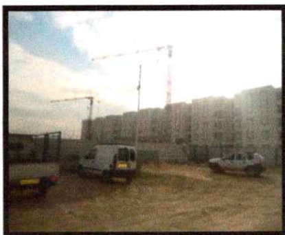
Figure 3. 59 Habitat collectifs en cours de construction
