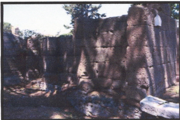
Figure 54 : Fondations non coffrées en opus caementicium (Castrum), source : archéologie construction romain
