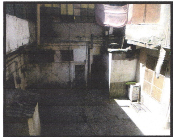
Figure 49 : Haouche (cour intérieure), source : l'auteur
