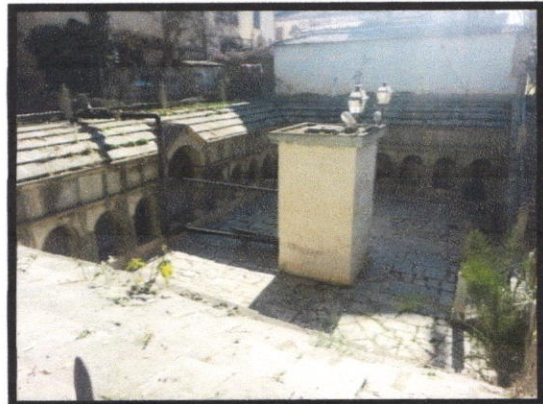
Figure 28 : château d'eau romain, source : l'auteur
