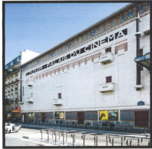
Figure 104 : Façade latérale, source : www.pumain.fr/cinema_le_louxo
