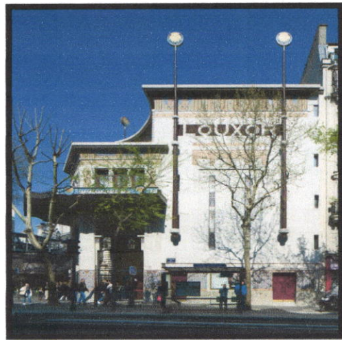
Figure106 : Façade latérale, source : www.pumain.fr/cinema_le_louxo
