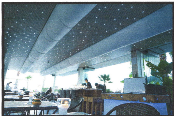
Figure148 : faux plafond pour cafeteriat , Source : https://www.google.dz
