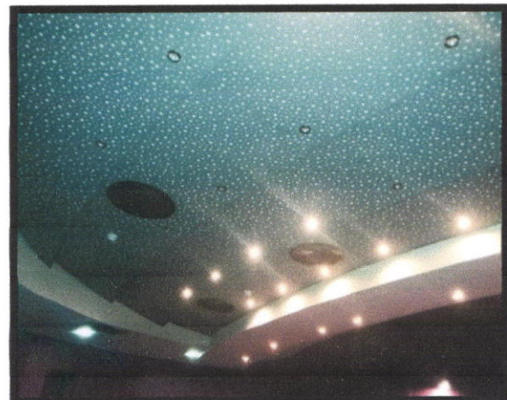
Figure136 : Faux plafond de la salle, source : L'auteur
