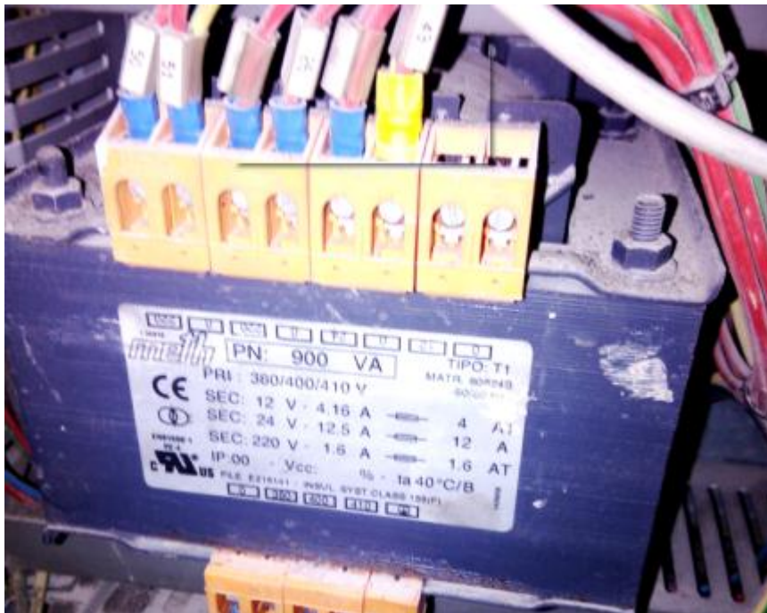
Figure 2.17 : transformateur.
