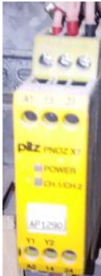
Figure 2.18. Relais de sécurité
