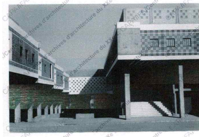
Fig. 17 : La présence abondante des pilotis dans le centre commercial Saint Réparatus
