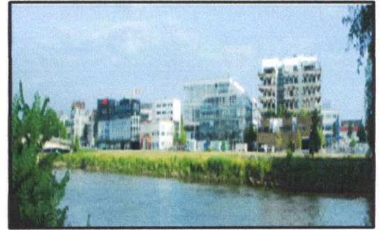
Figure .15: Le Quai François Mitterrand: logements, bureaux, école d'architecture sur la Loire
