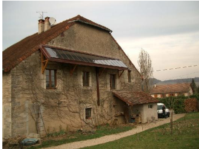
15- un panneau solaire en marquise (Source 52)
