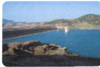
Fig. I.20: Le barrage de Boukourdane, Sidi Amar, Tipaza
