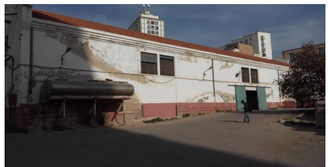
photo16: vue sur la façade sud de l'édifice
