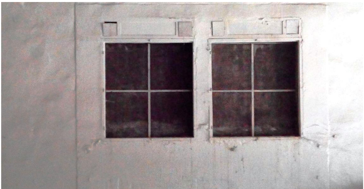
photo23: photo montrant les poutres utilisé pour les fenêtres
