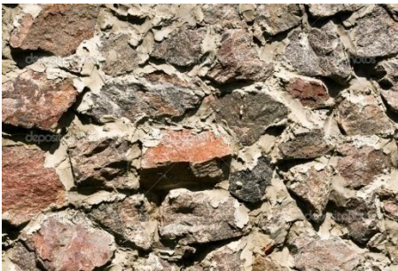
photo20: mur en moellon
