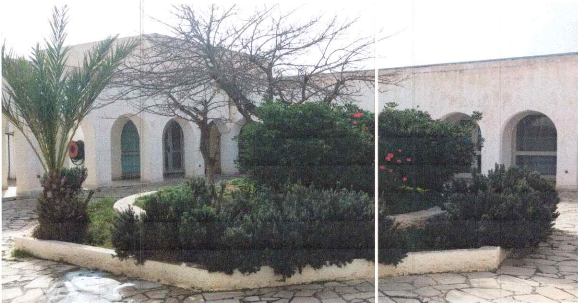
Fig.3.25 : Photo d'un patio du Village Artisanal.
