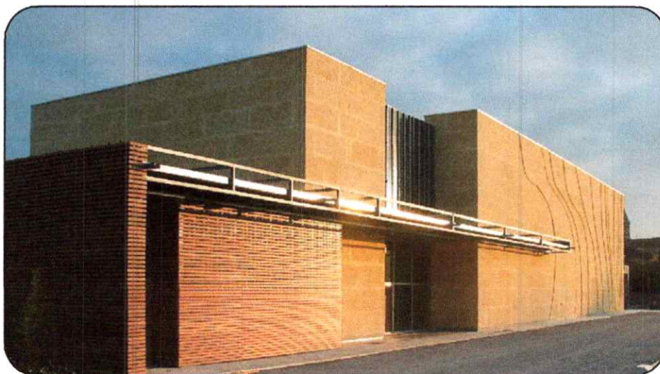
Figure 28 : Vue sur la façade principale du Centre culturel de Mireval
