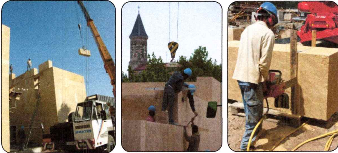
Figure 29 : Techniques de pose et découpage dans le chantier
