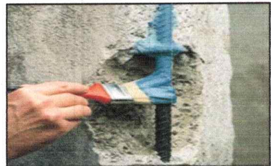
Figure2 : Utilisation de peinture hydrofuge contre la corrosion.
