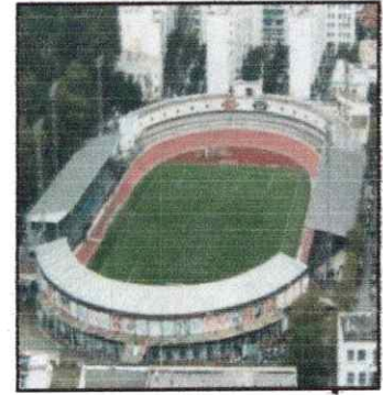
Figure6 : Stade 20 Aout Src : auteur 2016
