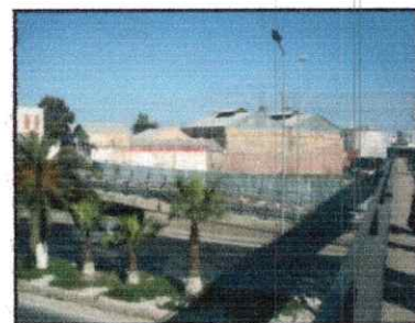
Figure4 : Les Hangars Src : auteur 2016
