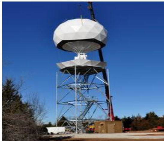
Figure 1.1 : Radar météorologique Doppler
