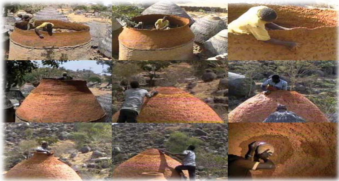
Figure 36: Construction d'une Huruk à Sukur, source:
