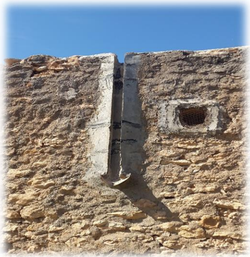
Figure 66: Détail de l'ouverture, et l'évacuation de l'eau pluviale, source: auteur.
