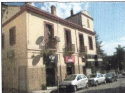
1-Mortier d'enduit recevant plusieurs couches de peintures Pour un plein lisse
