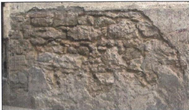
Mur en maçonnerie mixte brique plein -moellon
