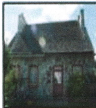
711, boulevard de Chénouan, Repentigny.
