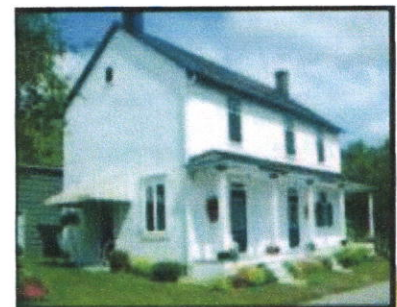
12, rue Hénault, Ville de L'Épiphanie Élévation de deux étages.
