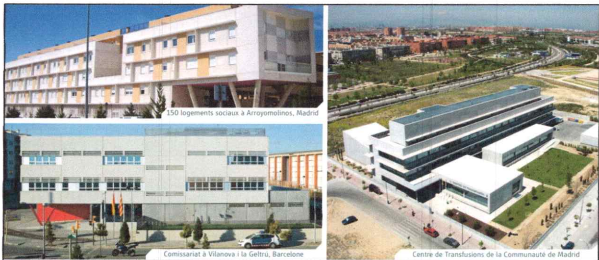
fig. 3536.37. Des exemple de projet réalisé en béton préfabriqué
