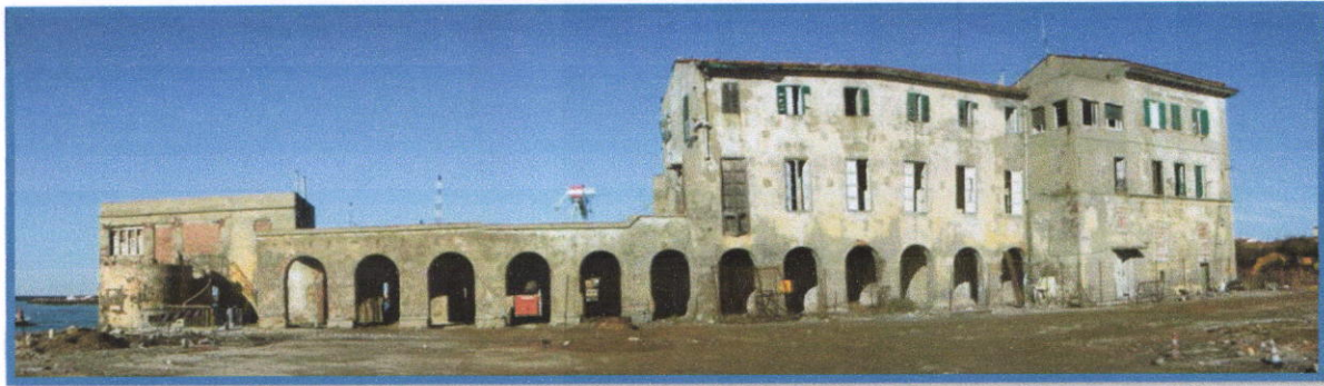
Fig.14 : image de l'équipement entrain les travaux
