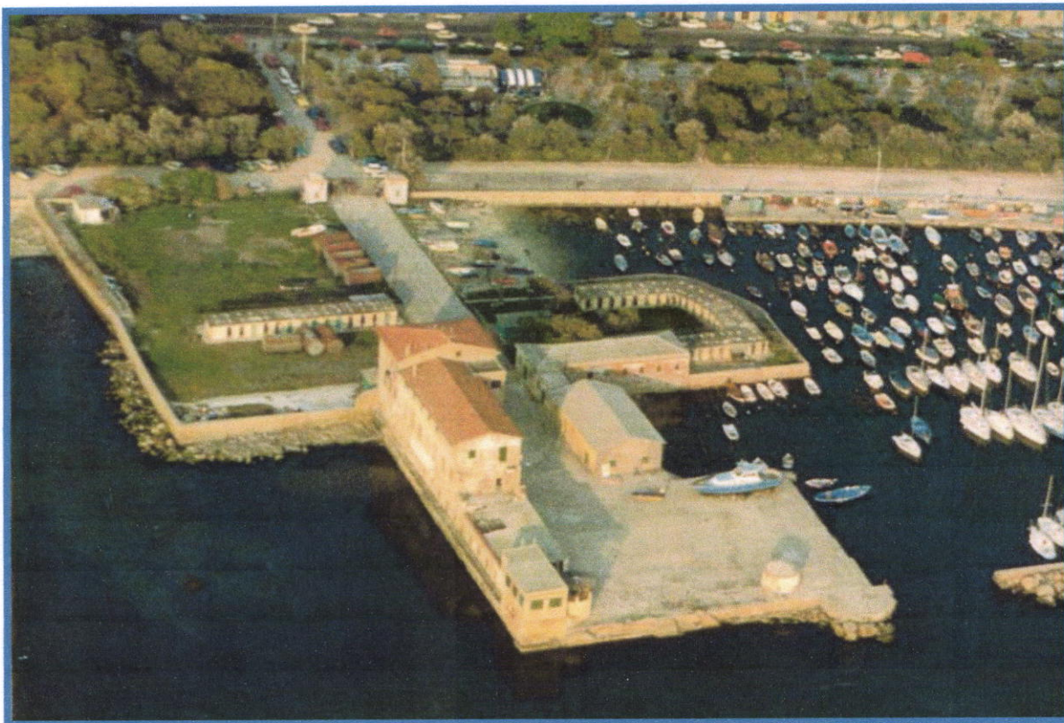
Fig13 : Vue générale du complexe Scoglio Della Regina La partie de la place dans le coin supérieur gauche au nord du pont, est déjà éliminé dans les travaux antérieurs Aussi bien que les volumes utilisés comme cabines situées à l'axe du nord et au sud du pont. L'image a été prise en fin des années 80.
