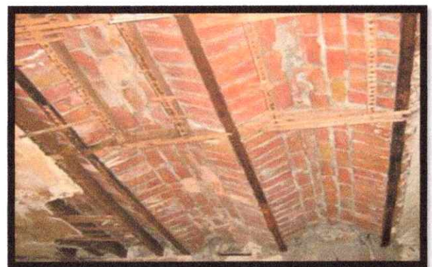
Fig.57 : remplissage d'un plancher.
