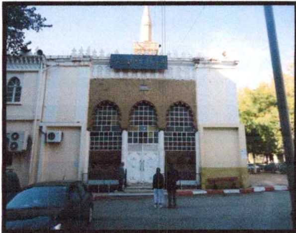
Fig.85 : vue sur la façade de la mosquée el Atik.
