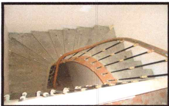
Fig.87 : vue sur les escaliers d'immeuble de rapport.
