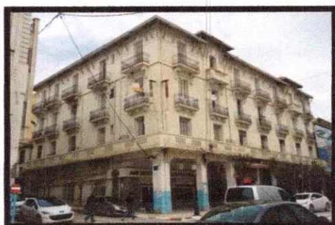
Fig.22 : Immeuble de rapport
