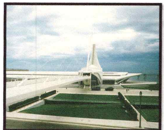
Fig.81 : vue sur le pont de Reiman coté ouest.
