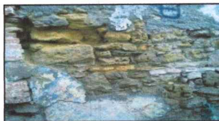
Figure23: mur en pierre
