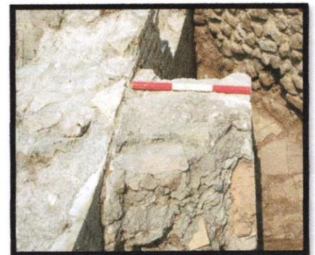
Fig.49 : Détail du blocage de murs à parements de Briques (château d'eau).
