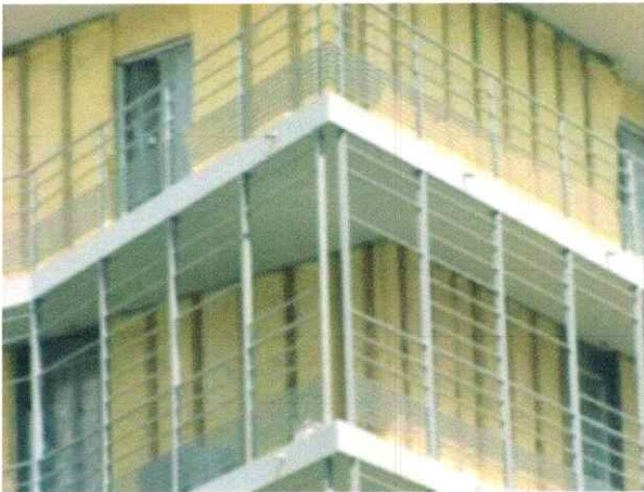
Sur-isolation par l'extérieur
