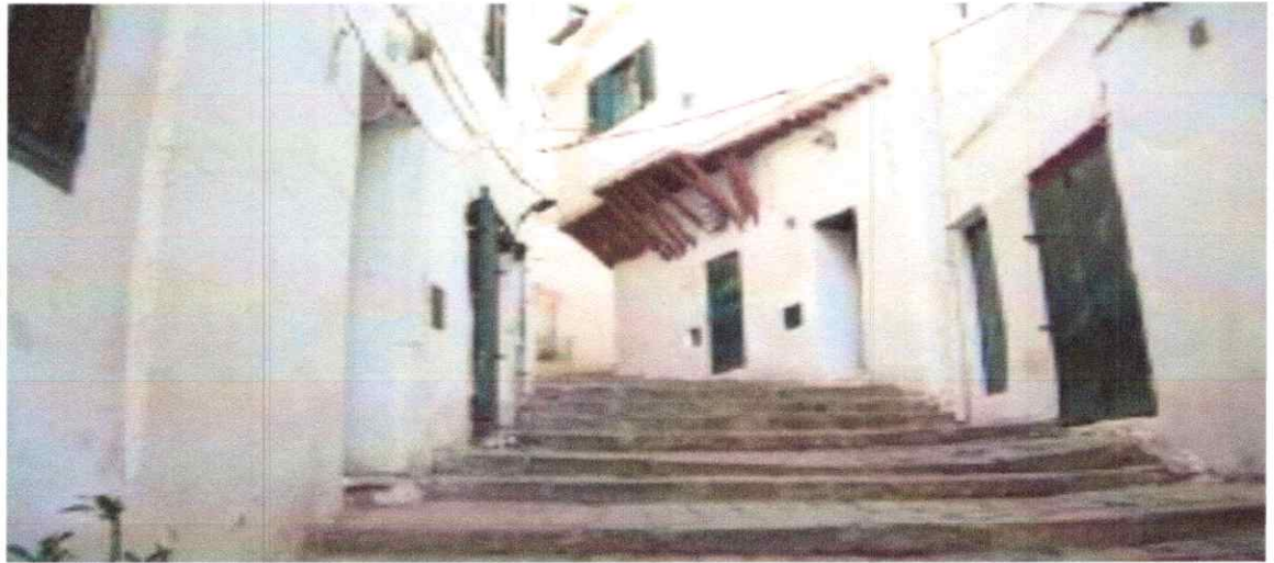
Fig15 : vue sur mur extérieure de Casbah
