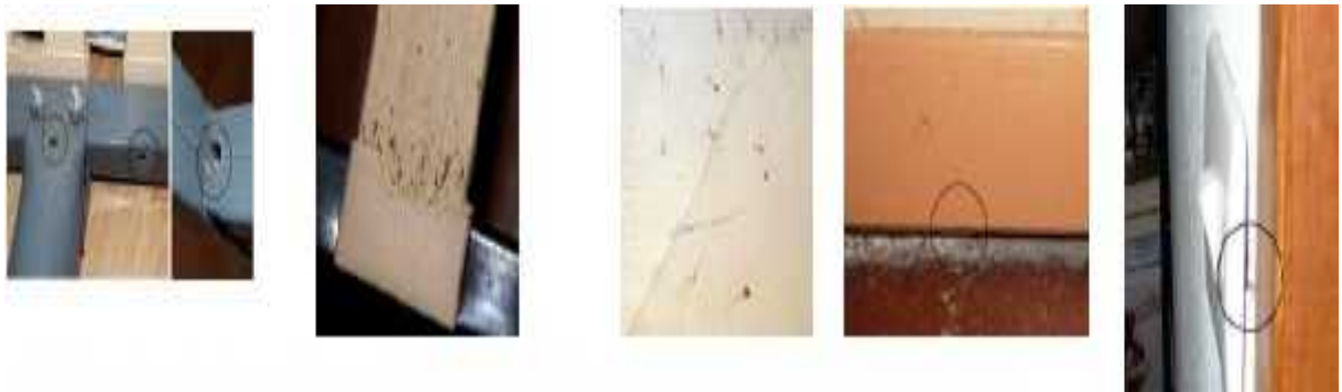
Figure 17 : Représente les différents lieux à inspecter. [50]
