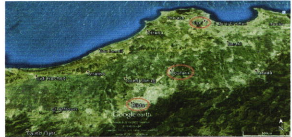
Figure 44 : Carte de situation de la ville de Boufarik. Source: Google Earth. (Auteurs)
