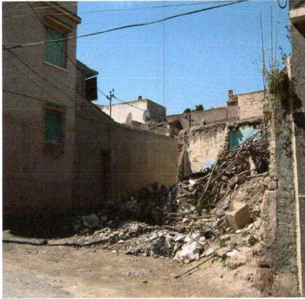
Figure 43 : photo présente l'état de bati dans l'interface portuaire de la ville.
