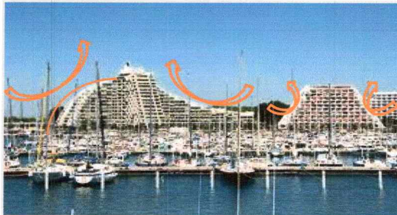
Figure 9 : photos présente la dégradation des formes pour diminuer les vents.
