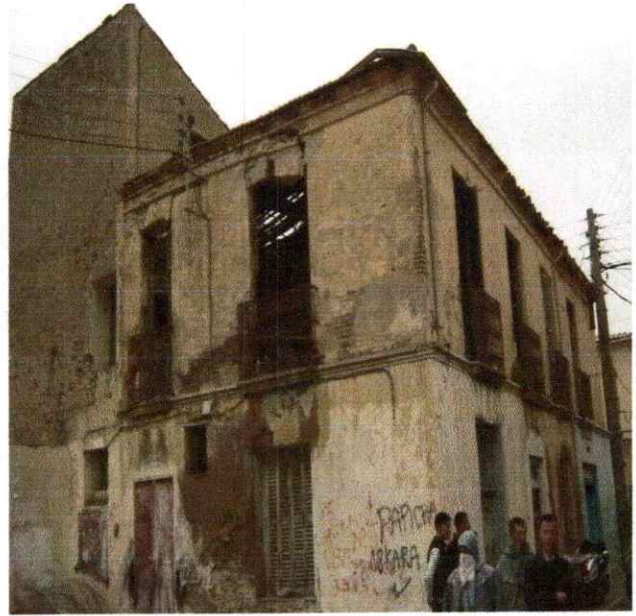
figure 44 : photo présente l'état de bati dans l'interface portuaire de la ville.
