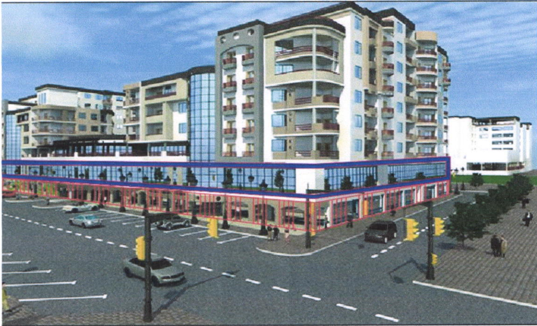
Utilisation des colonnes le long de la galerie du projet
