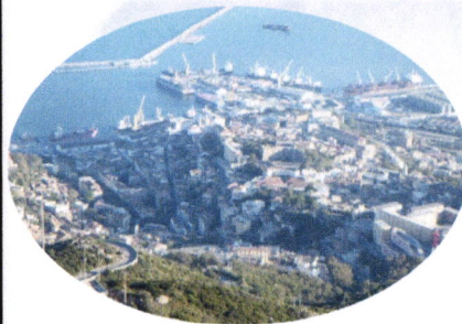
-Figure N°21: situation de la Gard Maritime
