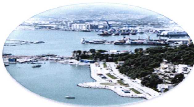
Figure N°12: montrant le mur de clôture qui entour le port.
