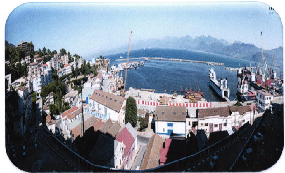
-Figure N°28: vue panoramique de la Zone D'intervention
