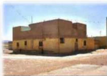
Aspect de modification extérieure apporté à l'habitat dans les VS.Pastoraux .
