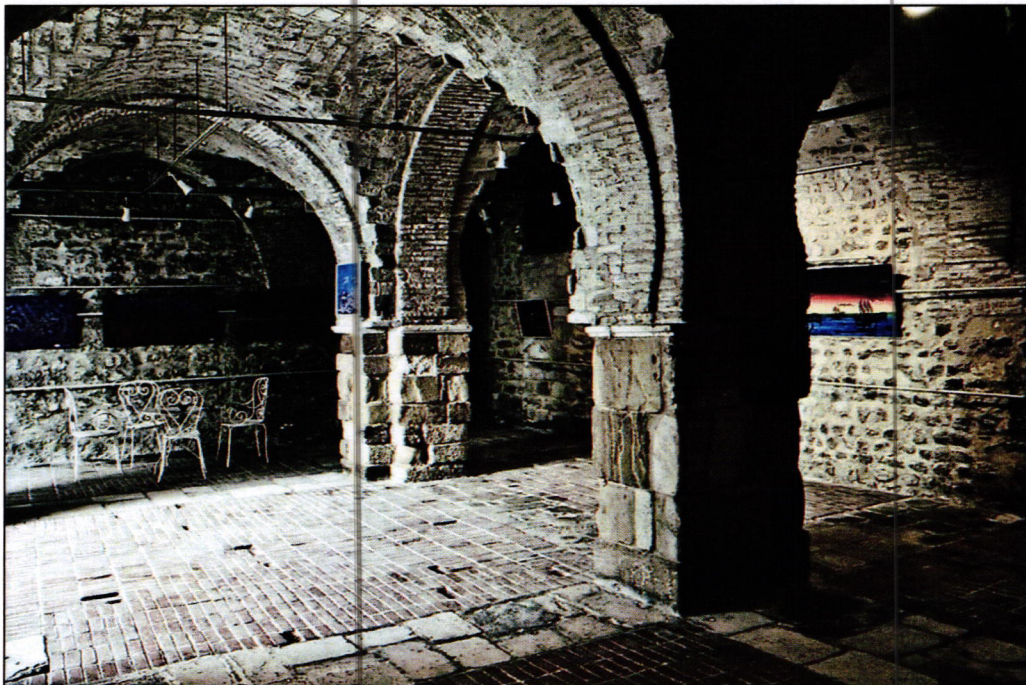
Figure 20 un sous-sol restauré et aménagé.
