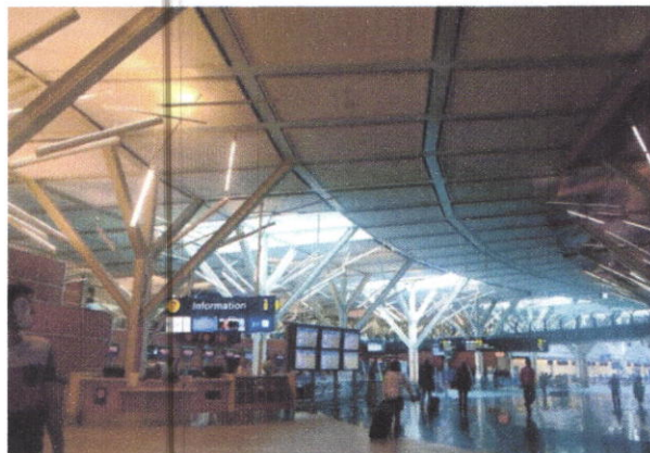
Figure 42 : Poteau arborescent (en treillis)
