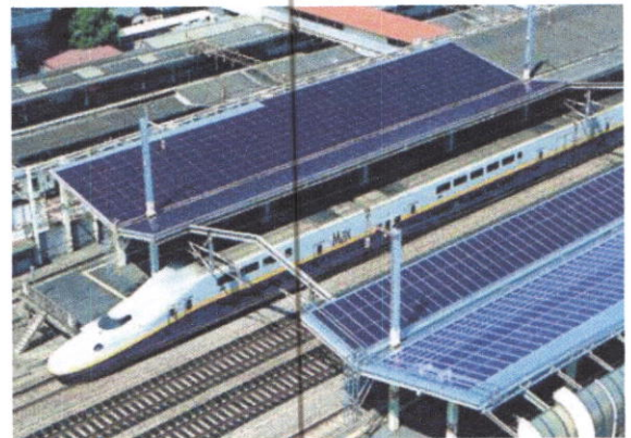
Figure 61 : Gare Gunma JAPON Source : Mitsubishi Electric, 2012
