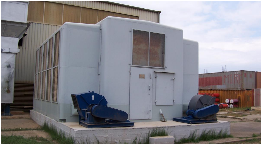
Figure 2.4: chambre d'aspiration d'air
