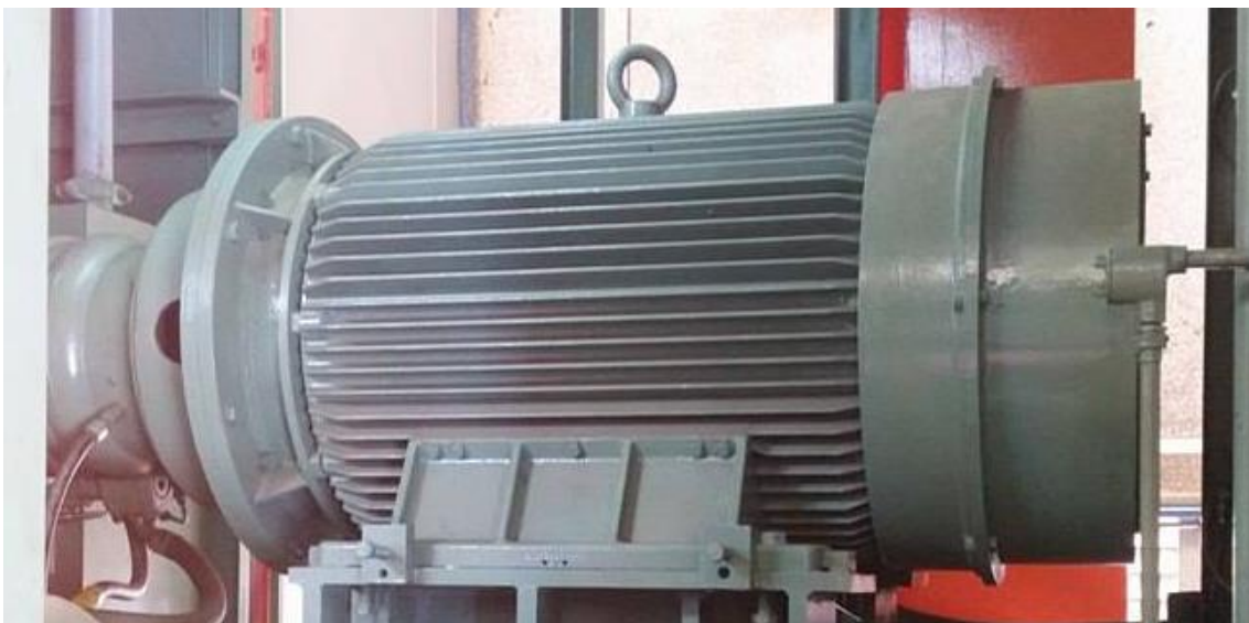
Figure 2.5: moteur de lancement.
