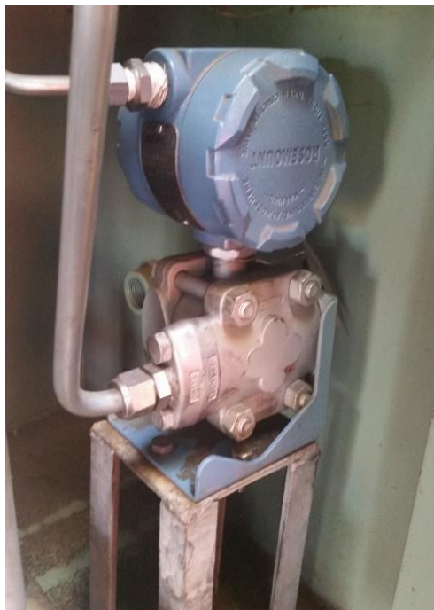
Figure 2.10: transformateur de pression (96CD).
