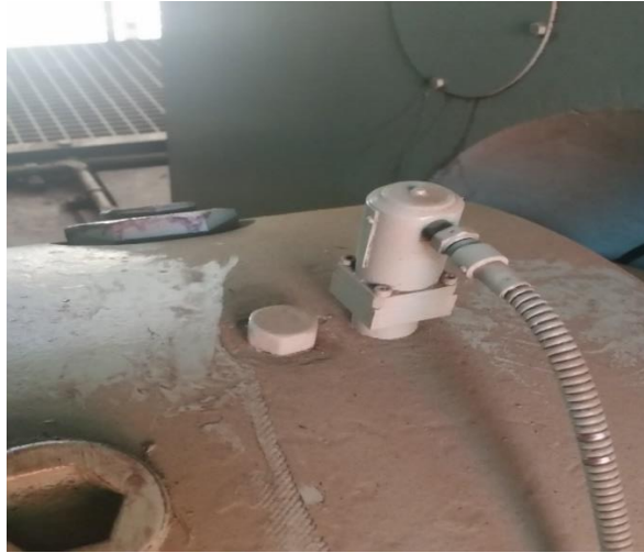
Figure 2.17: capteur de vibration
