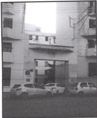
Figure42: accès mécanique Source: prises par l'auteur
