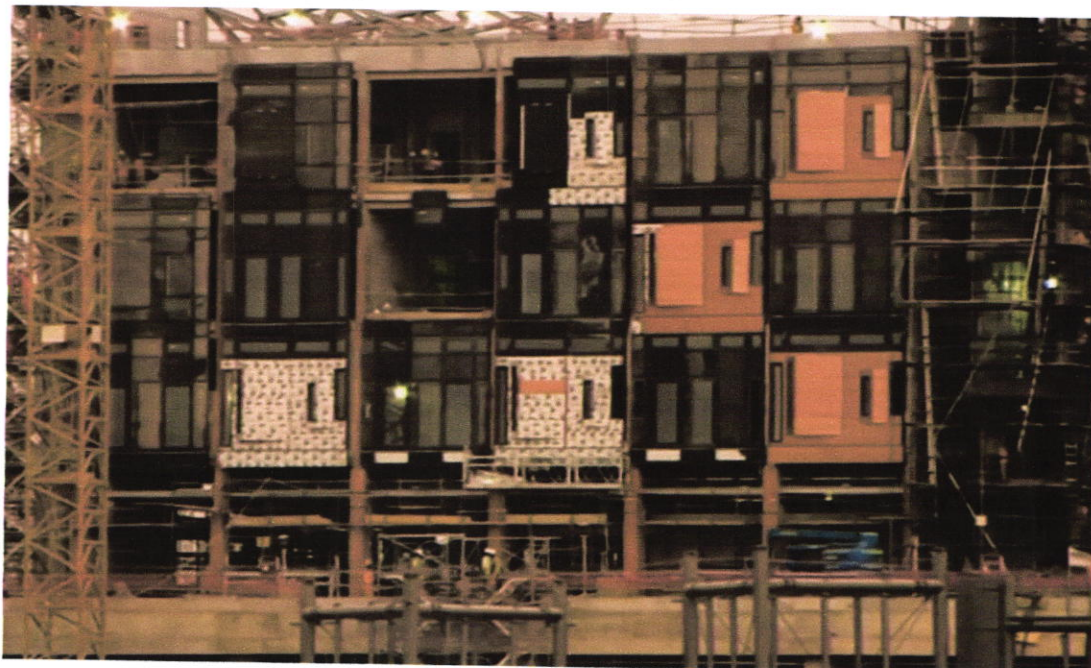
Figure n°=21 Montrant l'installation des panneaux BRV
