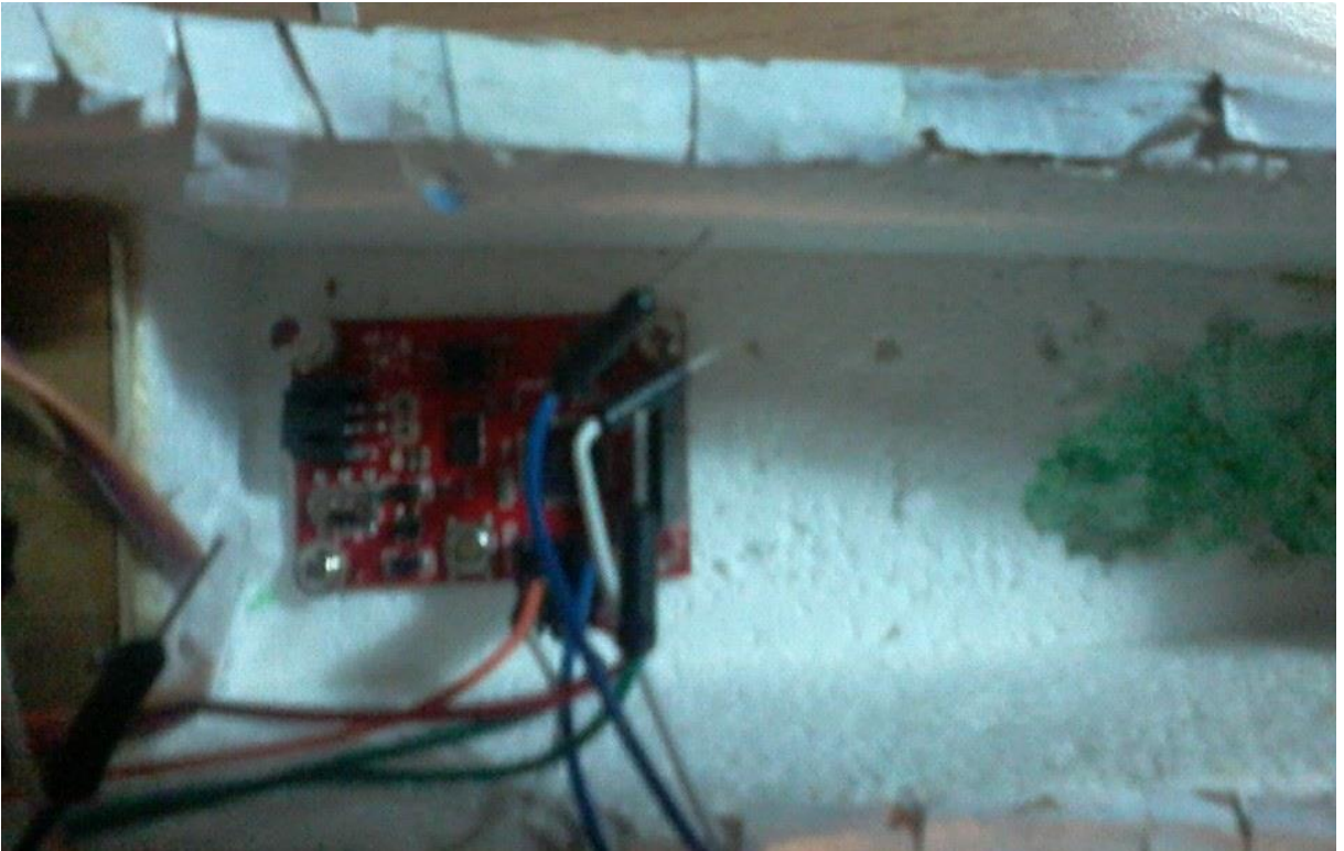
Figure III-10 L'emplacement de la centrale inertielle a bord du BR-50
